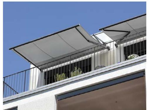
Abb. 146: Balkonmarkisen an einem Mehrfamilienhaus in Zürich-Affoltern
