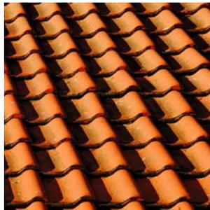
Abb. 139: Albedowert Dachziegel 0,1–0,35
