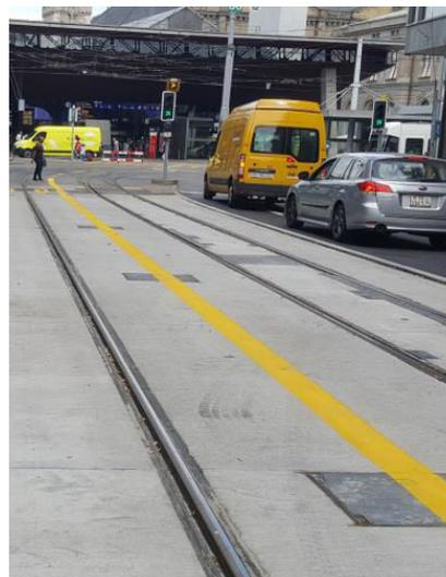
Abb. 113: Helle Betonfahrbahn an der Löwenstrasse
